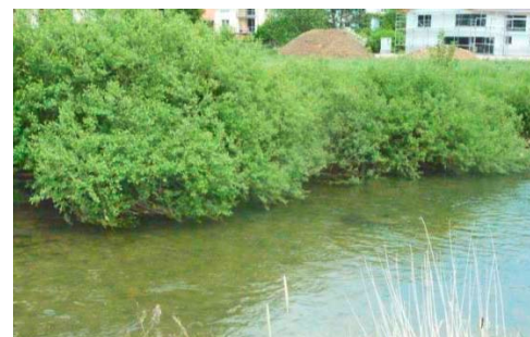
Bilder Jürg Knörr (Einbau von Weidenfaschinen)
